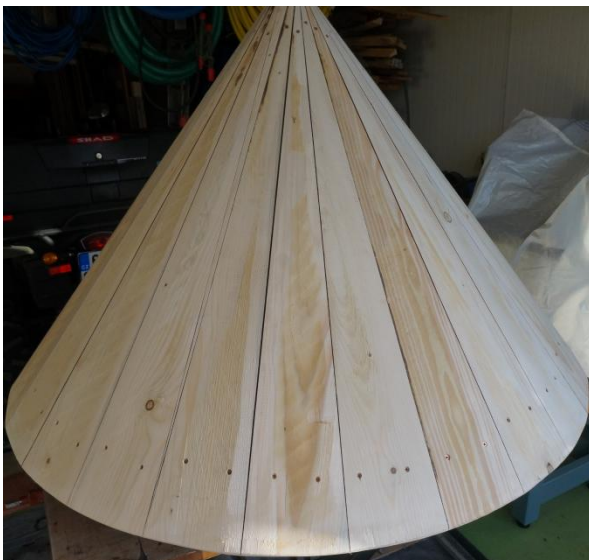
(Výroba repliky stříšky dle předlohy)
